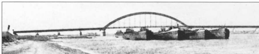
Schepen op de Lek bij de brug en de Lekbrug vernield, 5 januari 1945.
