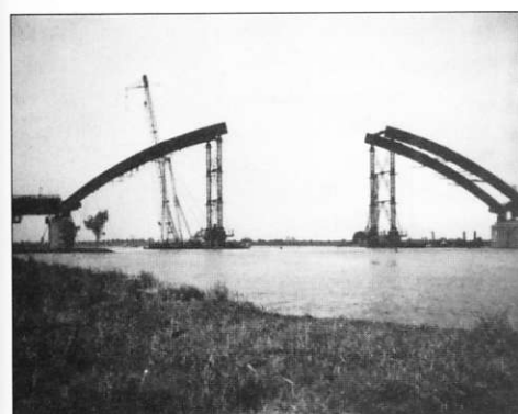
Van links naar rechts, van boven naar onder: De brug werd herbouwd vanuit de boogstukken en met behulp van enkele steunconstructies (1948).
