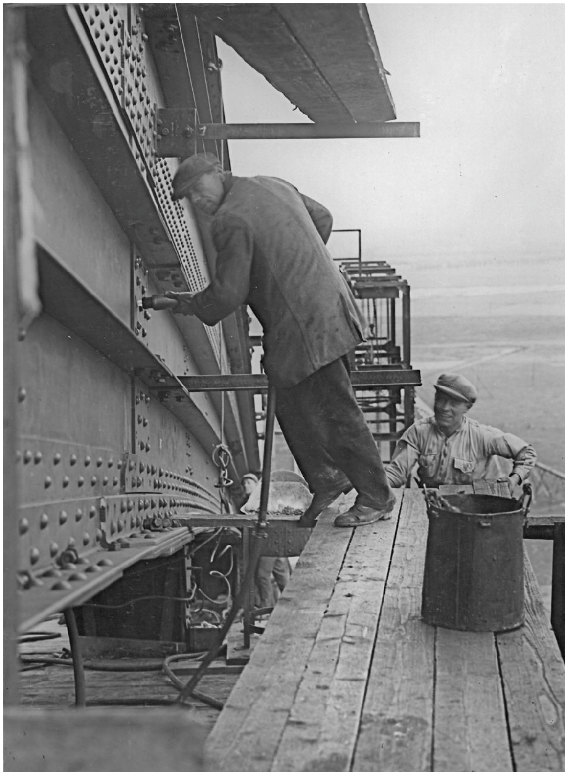
de brugconstructie werd in zijn geheel geklonken
