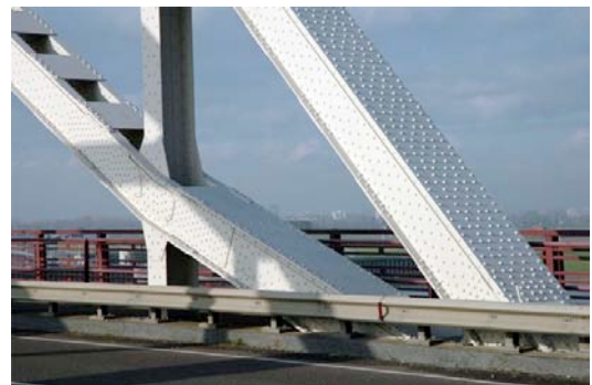
vakwerk in een boogconstructie
