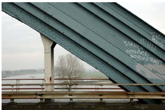
vier plooverstijvingen ter versterking van de platen
