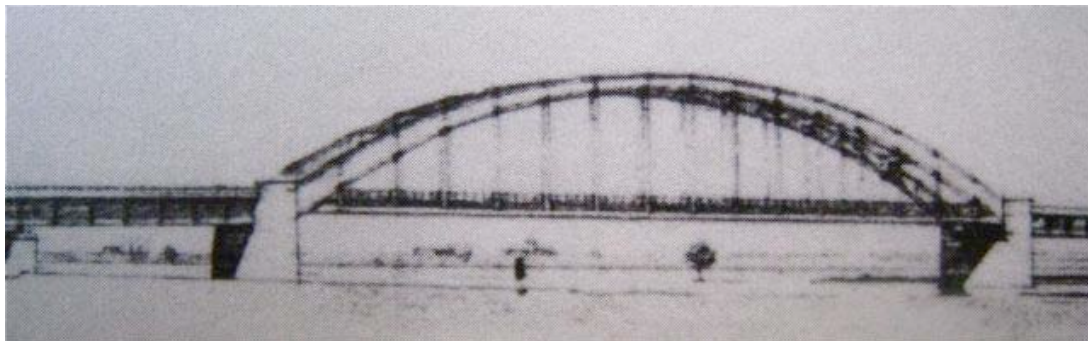
Eerste ontwerpschets van ingenieur A.J. van der Steur met bogen die bovenin dunner zijn en waarop men om esthetische redenen uiteindelijk koos voor bogen met een dikkere bovenkant.
