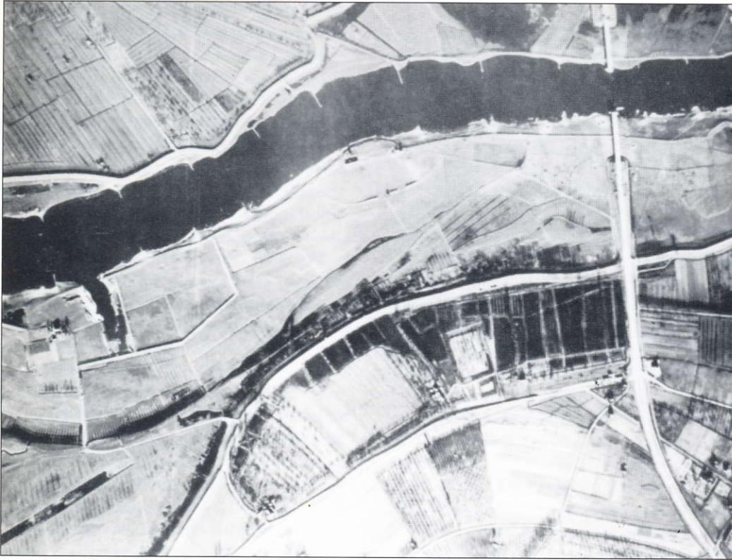
Op de luchtfoto (5 februari 1945) is niet alleen te zien dat de brug is vernield, maar ook dat vele bommen terecht zijn gekomen naast de oprit aan de zuidzijde (foto van zuid naar noord, rechts buiten beeld Vianen en Vreeswijk).
