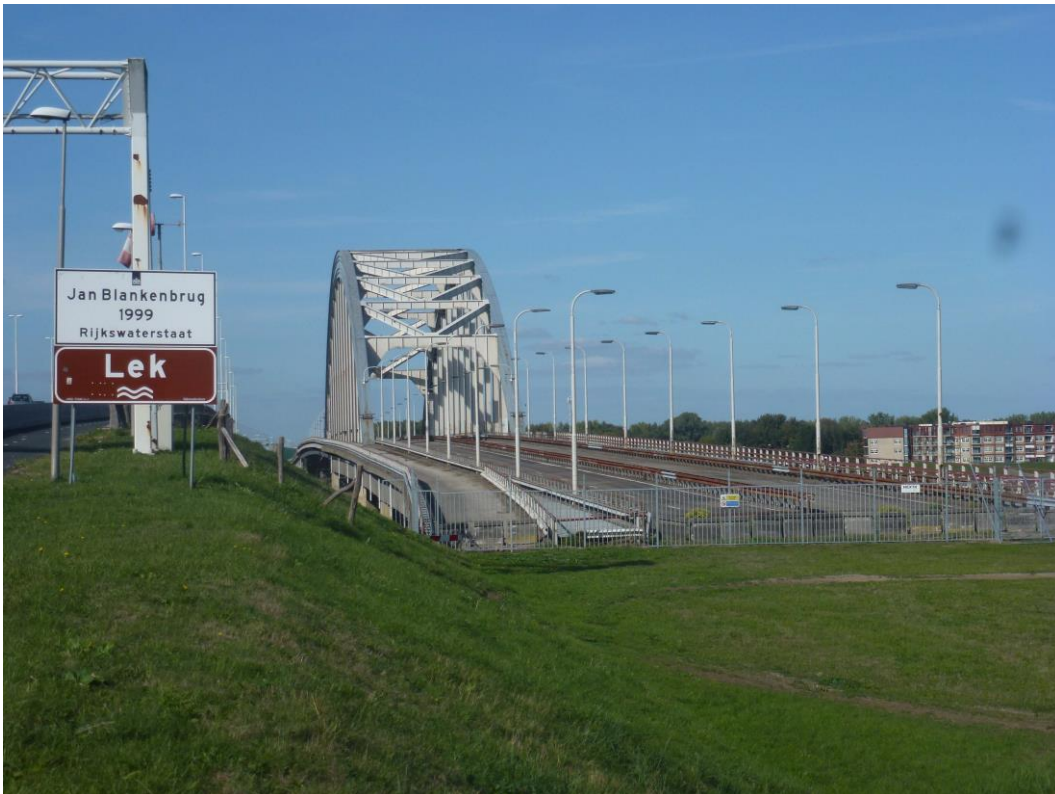
'Boogbrug Vianen' gelegen naast de Jan Blankenbrug, beeld van zuid naar noord [ foto jk 2018 ]
